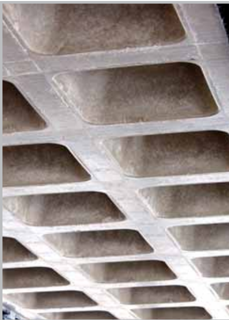
POUTRELLE T120: 140 X 750 X H 100 mm - Poids: 1,80 Kg
