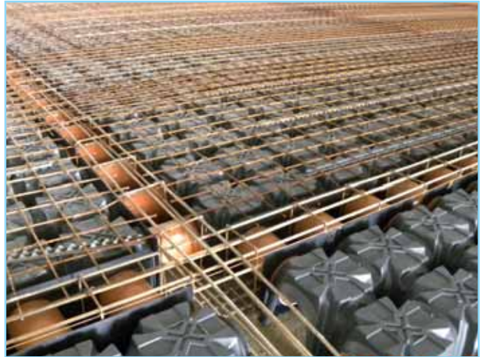
fig. 24) PADOVA • Cellule frigorifique 5970 m 2
