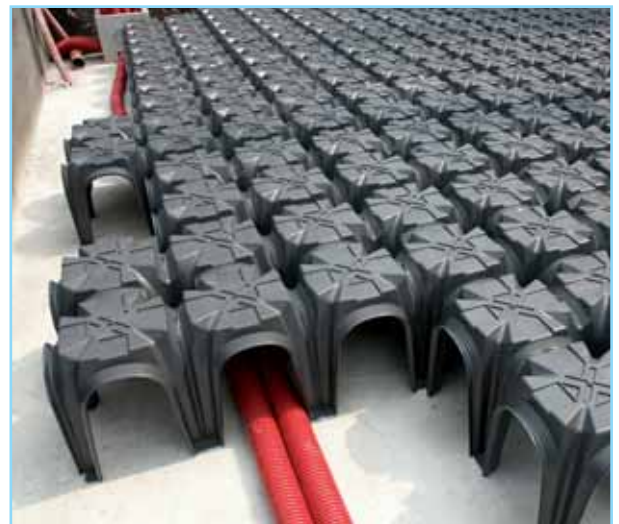
fig. 4) Installation du système MODULO FREEZE
