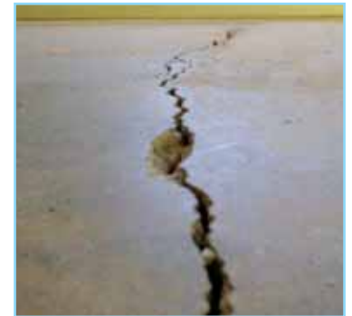
fig. 3) Dommage provoqué par cryoturbation.
