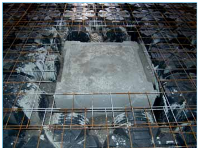
fig. 26) TORINO • Cellule frigorifique 5310 m 2
