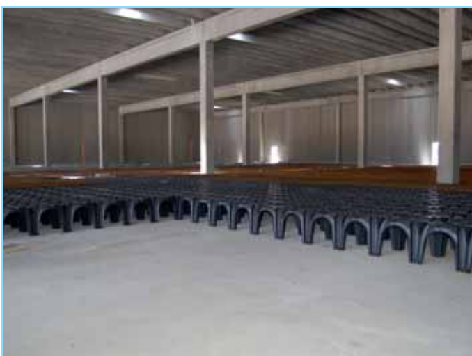
fig. 18) BRESCIA • Dépôt Frigorifique 5815 m 2
