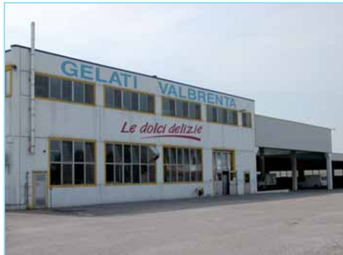
fig. 15) PADOVA • Cellule frigorifique 5320 m 2
