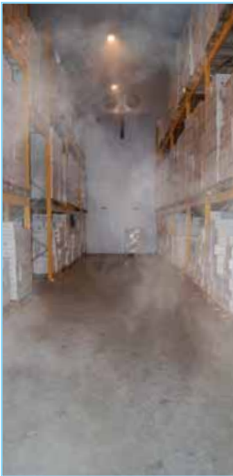
fig. 1) Intérieur d'une cellule frigorifique.
