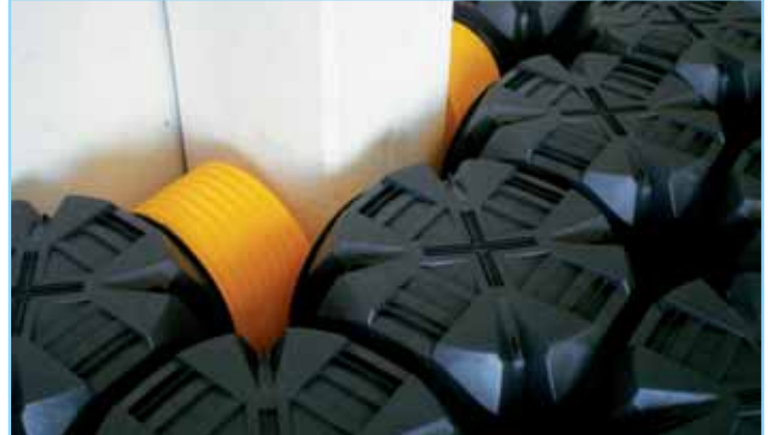
fig. 9) Exemple de compensation en proximité d'un poteau.
