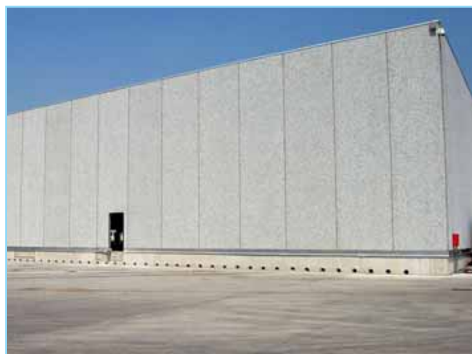
fig. 19) BRESCIA • Dépôt Frigorifique 5815 m 2
