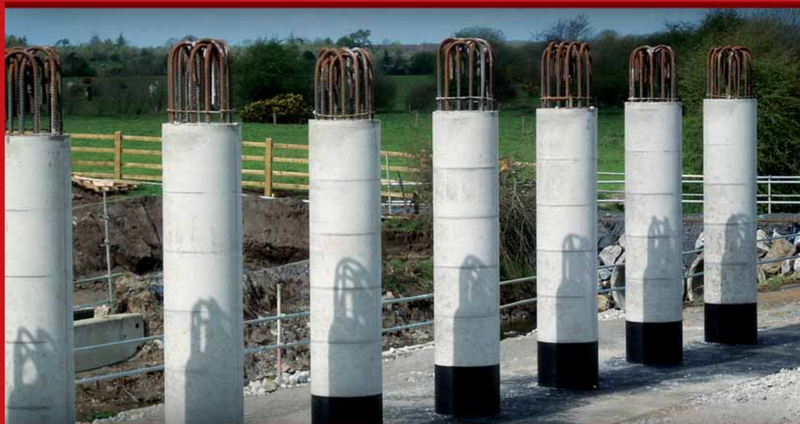
Le 1 ER coffrage pour piliers circulaires
